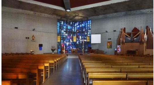
La couverture de la nef est un élément architectural novateur pour l'époque. Il constitue dans cette construction la deuxième utilisation de la technique d'auto-portage bétonné avec la couverture du narthex, mais ici dans des dimensions plus imposantes. Cette structure
